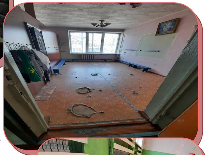
Имеются протечки крыши. Имеется отслоение штукатурки от стен. Сан узел полностью в нерабочем состоянии. Защитные конструкции системы отопления (радиаторов) имеют повреждения в виде сломанных деревянных реек. Напольное покрытие в раздевалках имеет разрывы, на стенах видны следы отслоения штукатурки, приборы освещения не соответствуют современным стандартам
