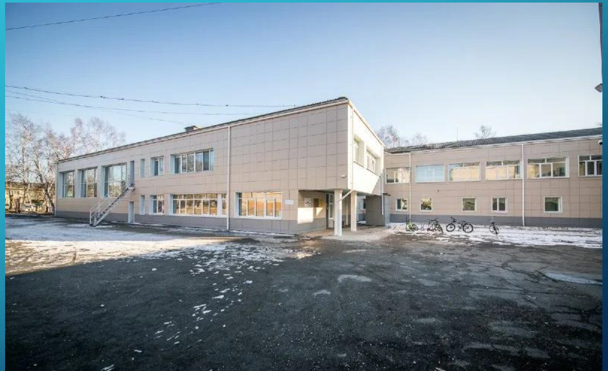
Произведен капитальный ремонт фасада МБОУ СОШ №6 п. Новый
