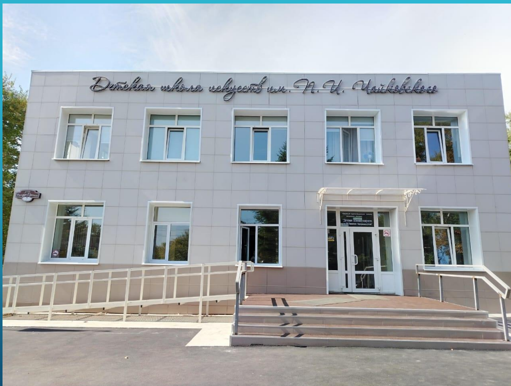
Капитальный ремонт фасада здания, кровли, 2 этажа здания ДШИ им. П.И. Чайковского
