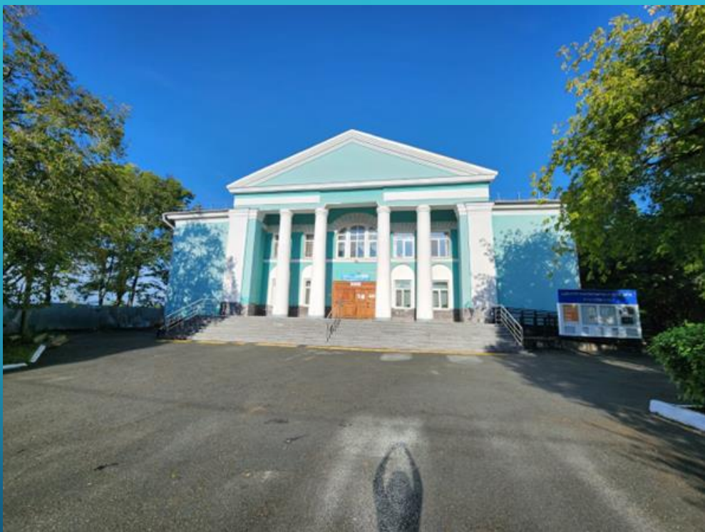
Произведен капитальный ремонт кровли здания Дома культуры с. Вольно-Надеждинское
